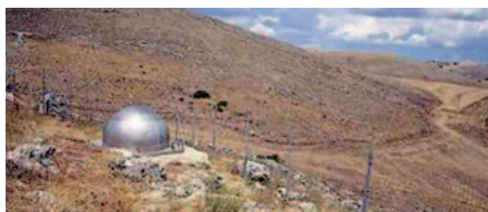
Accesso alla grotta protetto da cupola di acciaio
